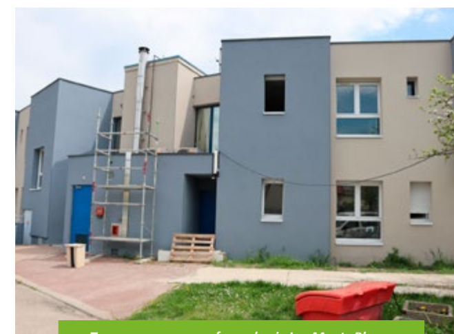
Travaux en cours au foyer de vie Les Monts Blancs
